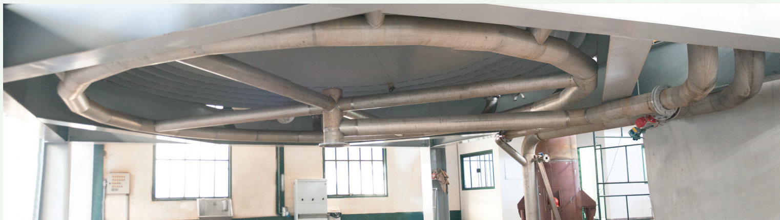
Flotador: modificação na serpentina de descarga para melhorar o escoamento é exemplo de “ajuste fino” da Indústria
